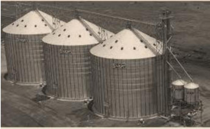
Observa-se que o silo, de fundo plano, é formado por um cilindro de altura 12 m e raio 3 m e um cone de 3 m de altura acoplado ao cilindro.
